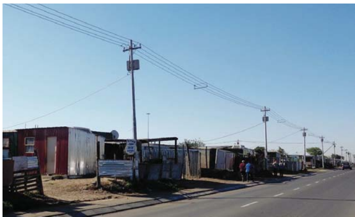
Les townships sont tous connectés au réseau électrique. (photo E.M)
